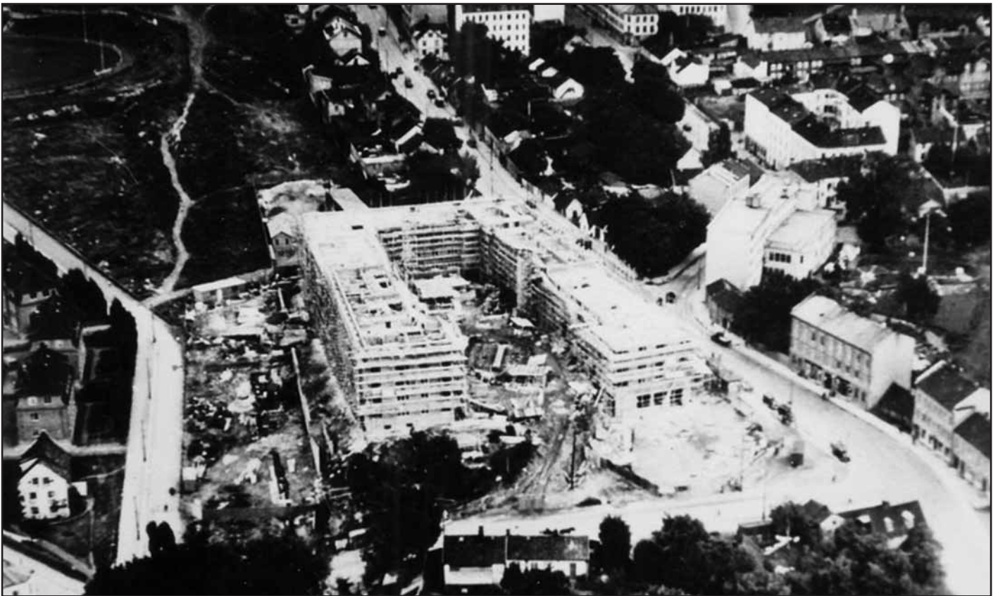
Bygginga av Galgeberg 3 midt på 1930-tallet. Til venstre husrekka i Jordalgata. Fotograf: Ukjent.
