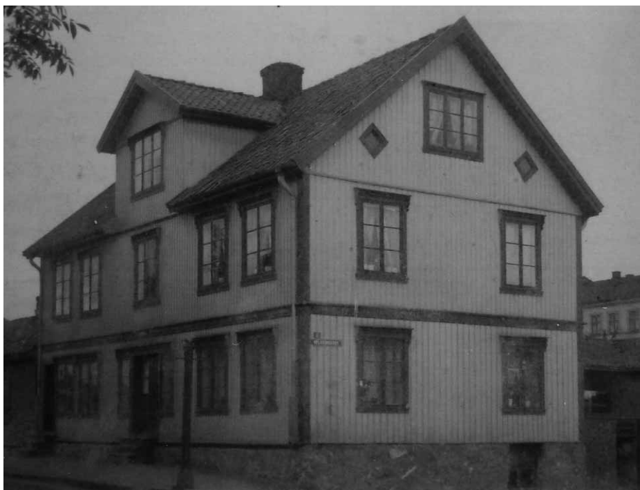
Slik ble huset i Opplandgata 2 seende ut etter ombygging i 1898. Bildet har vi lånt av Thor Gaarder.
