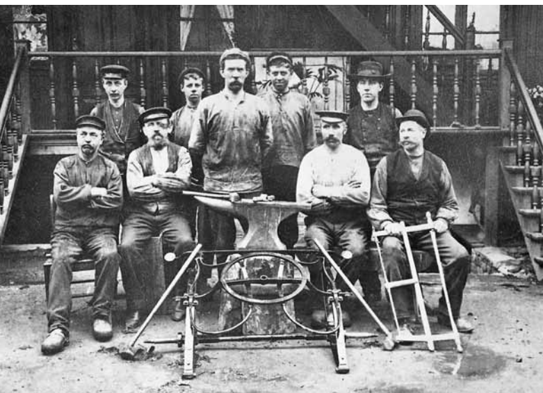
Baksiden av nr. 25A. Tærud foran nr. 2 fra høyre.
