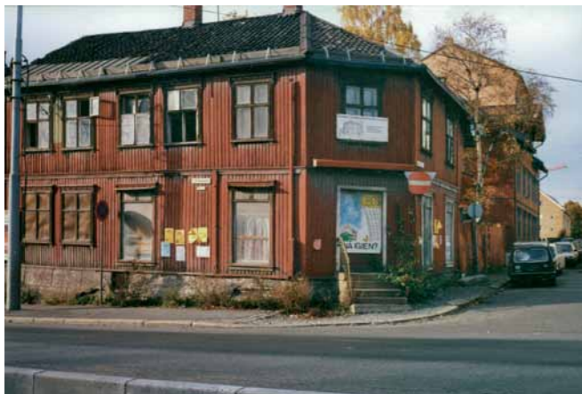
Så nedslitt var huset da Vålerenga vel fikk huset av kommunen.
