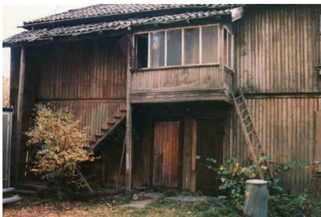
Den gamle trappa opp til annen etasje måtte vike for et nytt påbygg.
