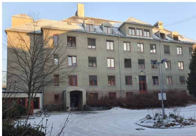
«Enga» slik den gamle bygningen fra 1917 ser ut i dag. Er det fortsatt håp for den?
